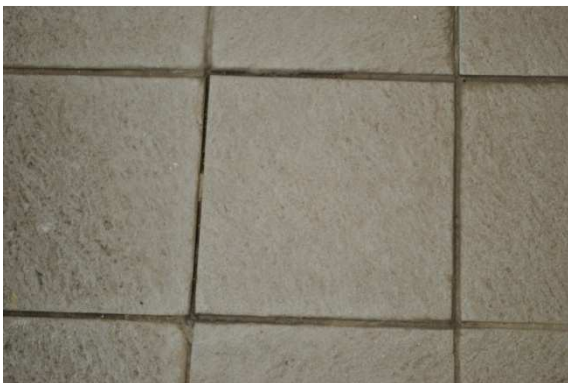
38. Sík-, és rajzolati fogas, fugahiányos burkolat
