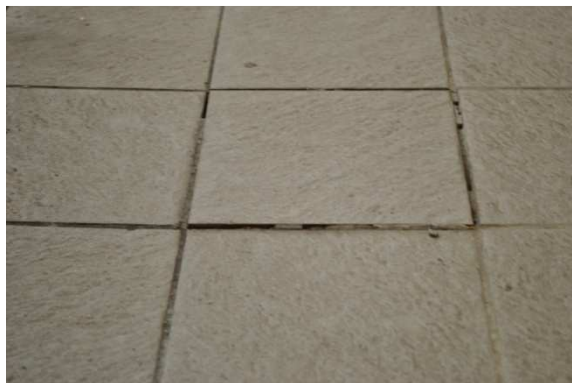
38. Sík-, és rajzolati fogas, fugahiányos burkolat
