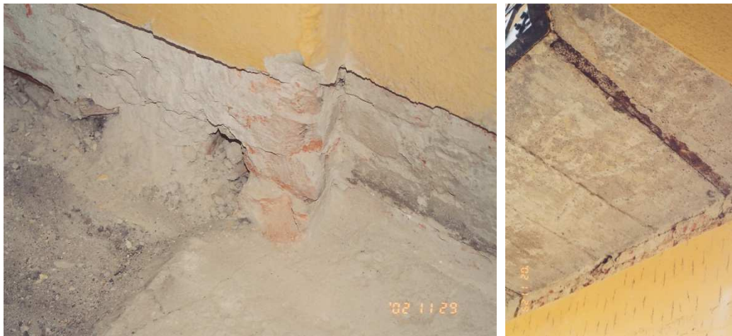
16. A vasbetonlemez és földémfeltöltés találkozásának feltárása, valamint a mennyezet-, és keskenyvakolat leverése
