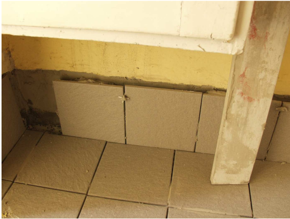
35. Burkolási hibák: nem a padlón áll a lábazat, a ragasztó réteg vastagsága meghaladja a 20 mm-t, a lábazat egyik oldalán sem merőleges a padlóra, azaz a tervezett síktól eltér
