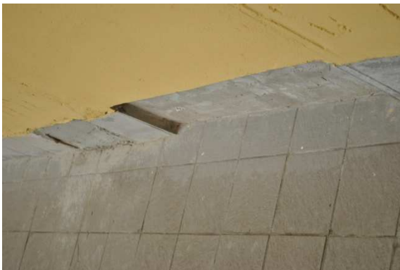
37. Leesett és fel sem rakott lábazatelemek, törött lap a burkolatban
