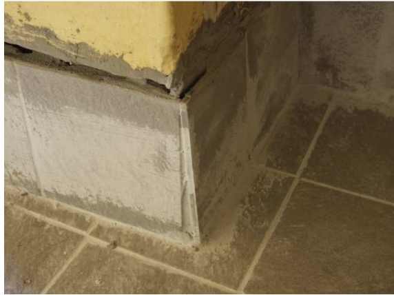
35. Burkolási hibák: nem a padlón áll a lábazat, a ragasztó réteg vastagsága meghaladja a 20 mm-t, a lábazat egyik oldalán sem merőleges a padlóra, azaz a tervezett síktól eltér
