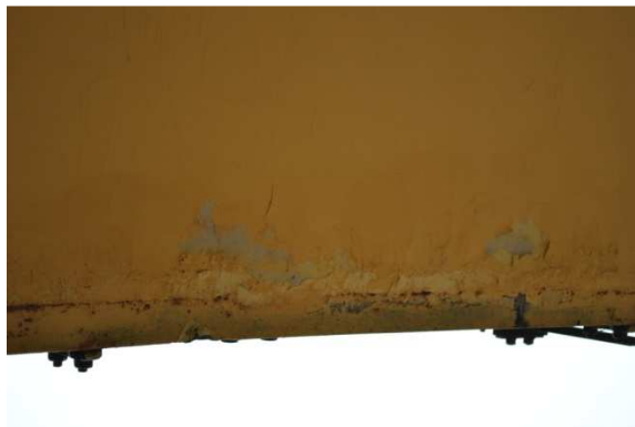
36. Látható a csapadék igénybevétele és a szigetelés, szegélyek, vízzor hiánya miatti átázás
