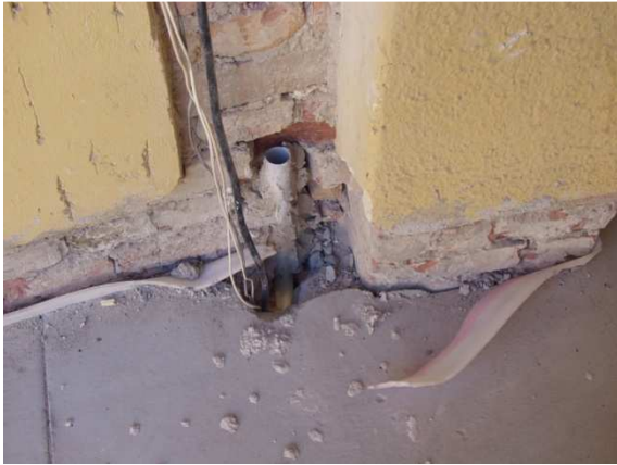
32. A későbbi kivitelező által készített „csőátörés” csomópontja hiányos miniumos alapmázolás, előkészítési munkák nélkül
