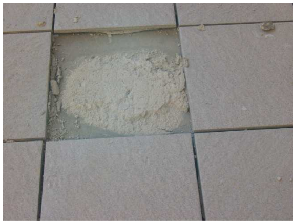
33. Hiányos lábazati alapvakolat készítése, valamint homokos ragasztóhabarcs helytelen használata (hiszen a legnagyobb feszültségeknek kitett sarkokon egyáltalán nincs kötőanyag)
