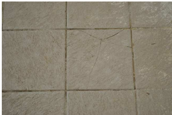
37. Leesett és fel sem rakott lábazatelemek, törött lap a burkolatban
