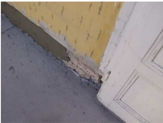
33. Hiányos lábazati alapvakolat készítése, valamint homokos ragasztóhabarcs helytelen használata (hiszen a legnagyobb feszültségeknek kitett sarkokon egyáltalán nincs kötőanyag)
