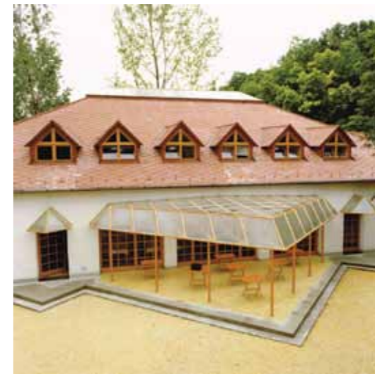
7. ábra. A BME Balatonkenesei mérőtelepének „A” közösségi épülete (terv: Szende Árpád)
