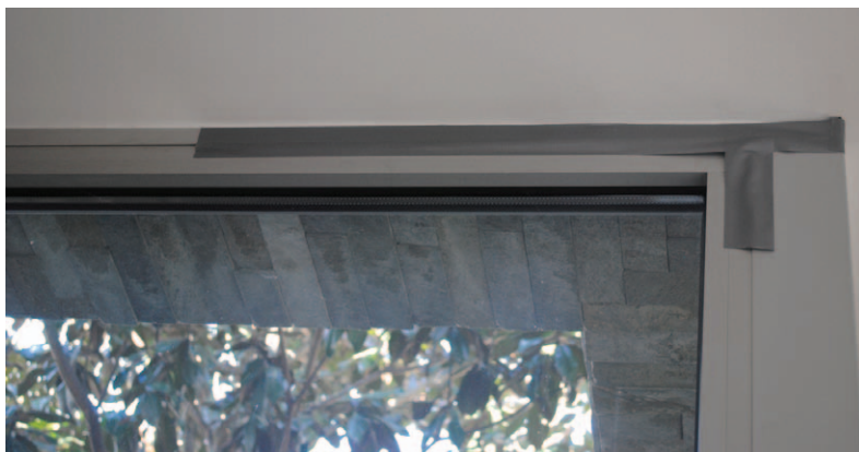
Az észlelt nyílászáróhibát leragasztással próbálták javítani
