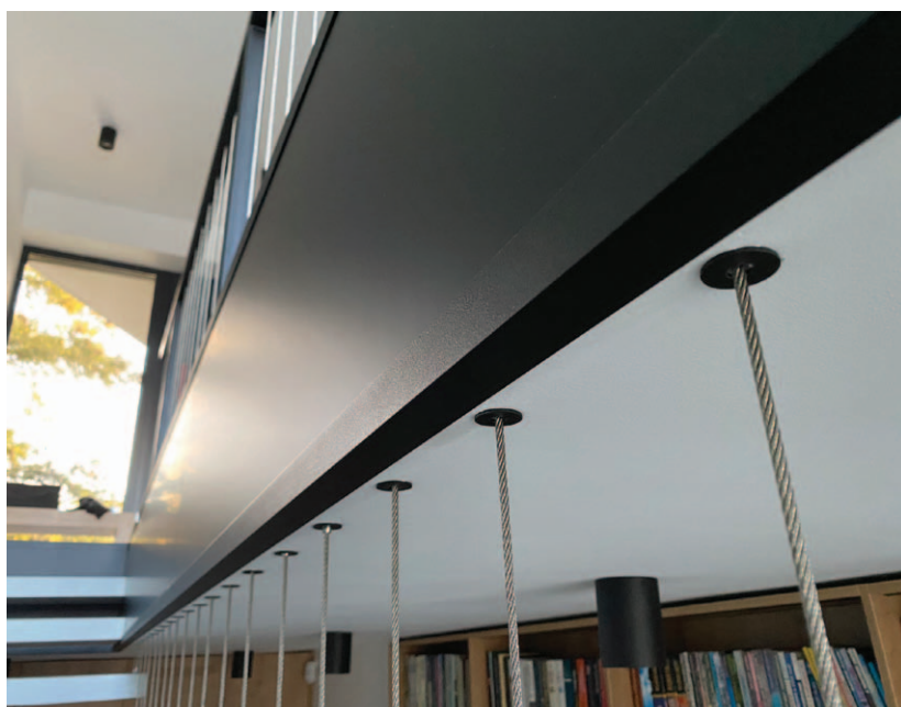
A falba acélszárakkal befogott beton lépcsőfokokat a külső oldalon sodronykötelek függesztik fel, és ez utóbbiak a korlát szerepét is ellátják
