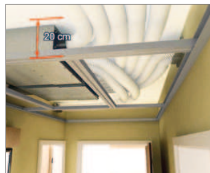
(Fenti kép) Hangszigetelt osztódobozok a csendes működés érdekében.
