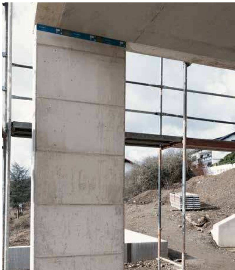
A Sconnex® elem karcsú, látszóbeton megjelenésű falat tesz lehetővé, a hőhíd problémájának tartós megoldásával.
