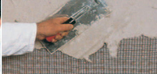
A vakolat egyszerű, vakolókanállal történő felhordása.
