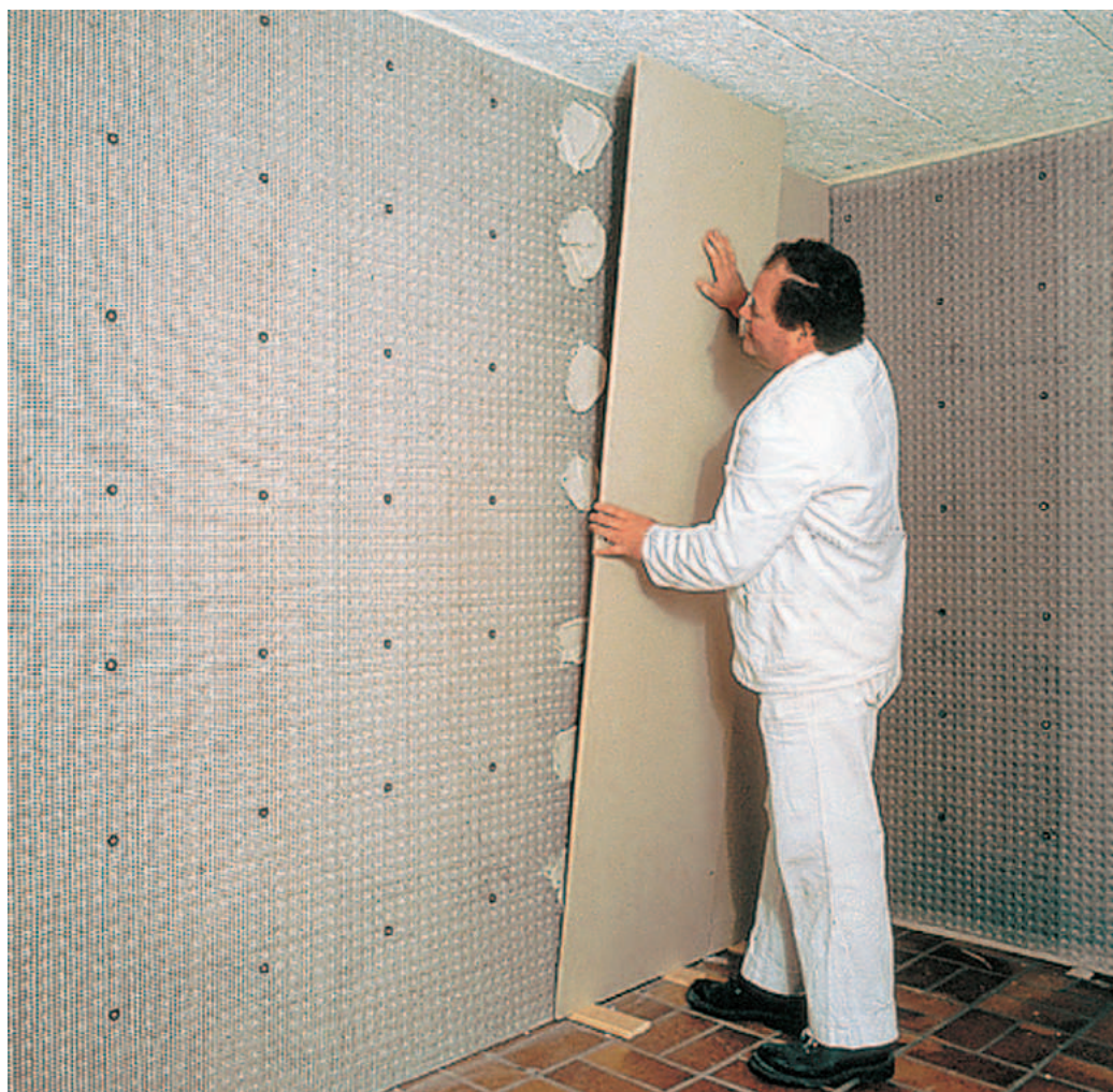
A DELTA®-PT szilárd alapot képez gipsz és mészcement vakolatok vagy gipszkartonlapok számára.
