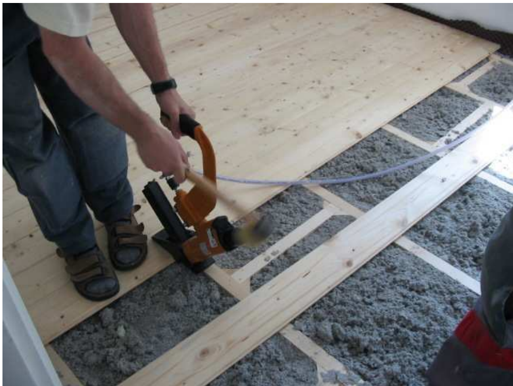
A hajópadló rögzítése a hőszigetelés fölött.
