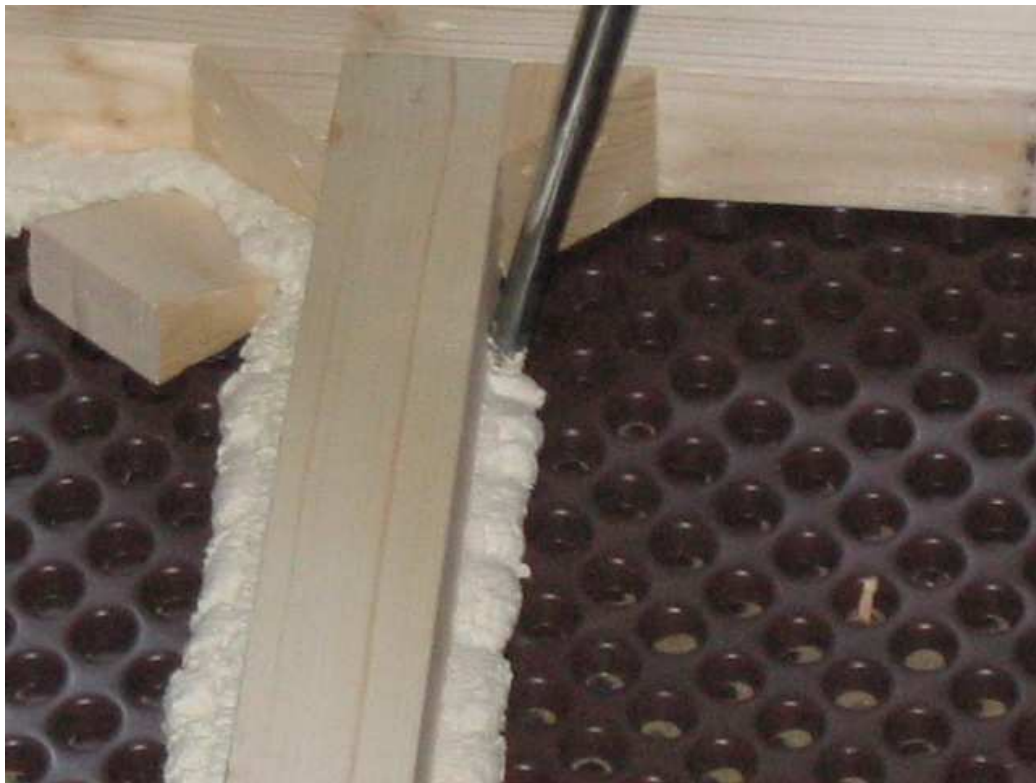
A párnafák rögzítése poliuretán habbal.
