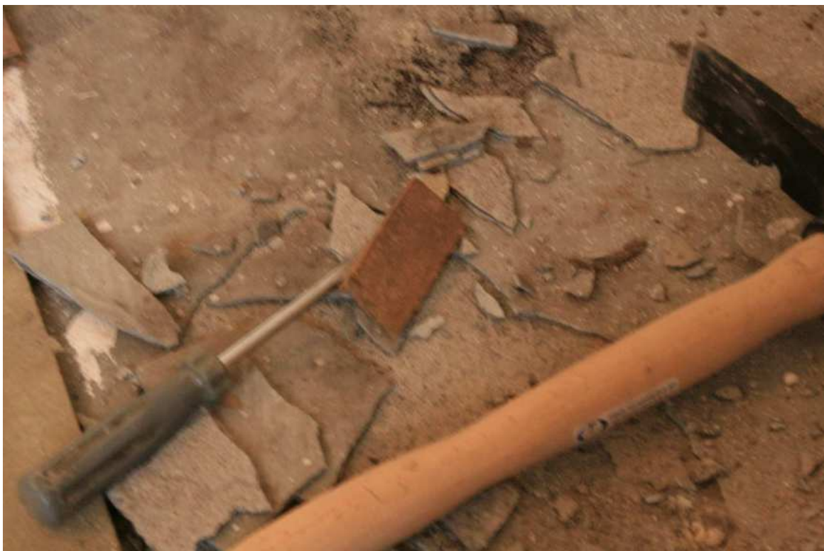
Padló szigetelés visszabontása
