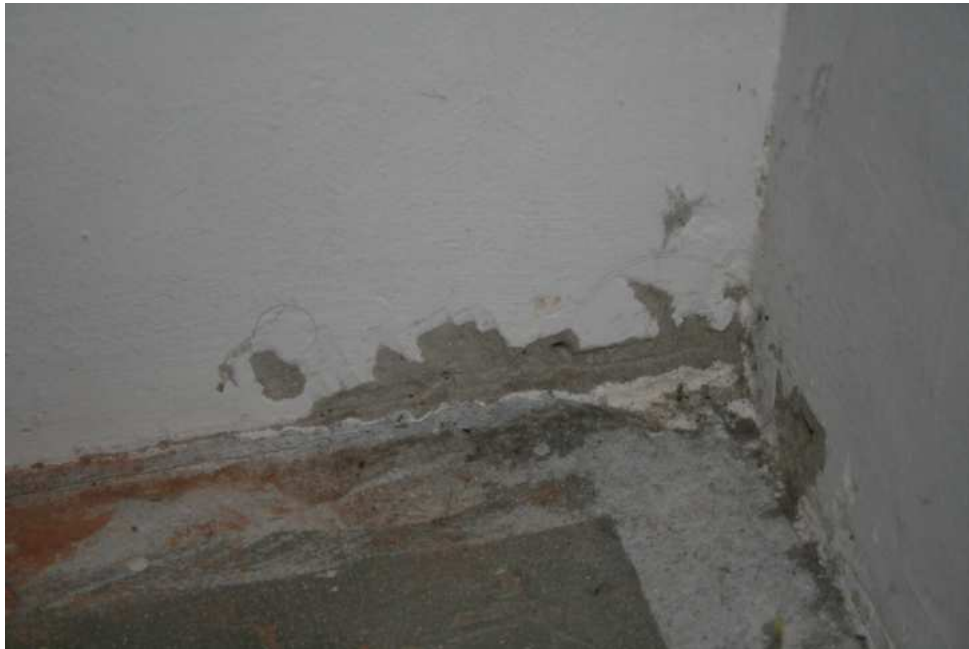
Cement alapú szigeteléssel leszigetelt padozathoz csatlakozó fal.
