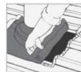
5. Vigye fel a tömítőanyagot és a Dektite-t formázza a tetőprofilra.
