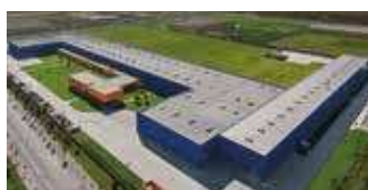
Hörmann Tianjin, Kína
