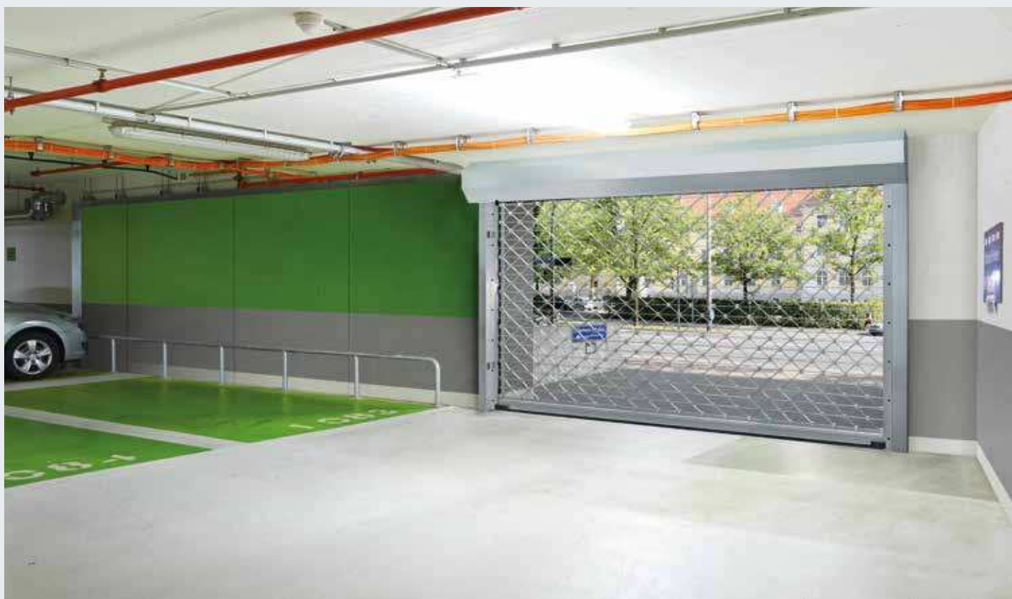
Az alapkivitelben adott erőhatárolás nagy biztonságot nyújt nyitáskor és záráskor, a kapulapra szerelt zavaró szenzorok nélkül (az ábrán TGT mélygarázs-redőnykapu látható WA 300 AR S4 meghajtással).
