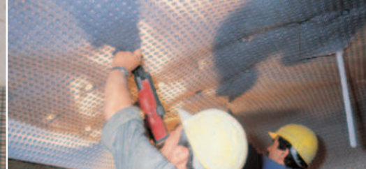
Alagútépítés esetén a DELTA®-PT löttbeton hordozórétegeként szolgál.
