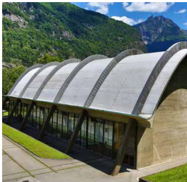
Beépítés éve: 1967 | Nuova Biaschina Vízerőmű, Personico, Svájc | Sarnafil® G 410-12
