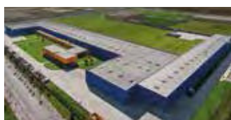
Hörmann Tianjin, Kína
