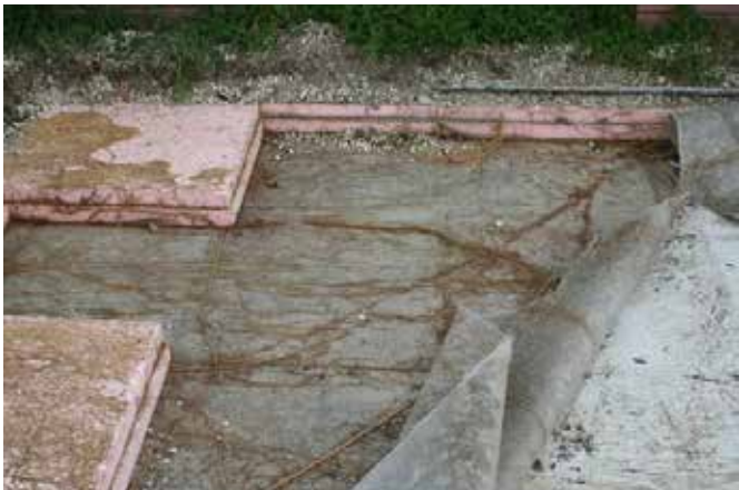
A gyökérzet a nedvességben oldott tápanyagot keresi a vízszigetelés síkján
