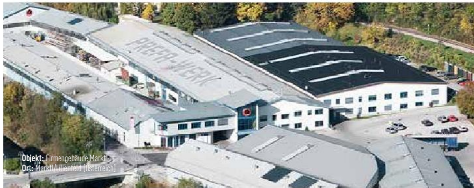
Objekt: Firmengebäude Wasungen Ort: Wasungen (Deutschland)
