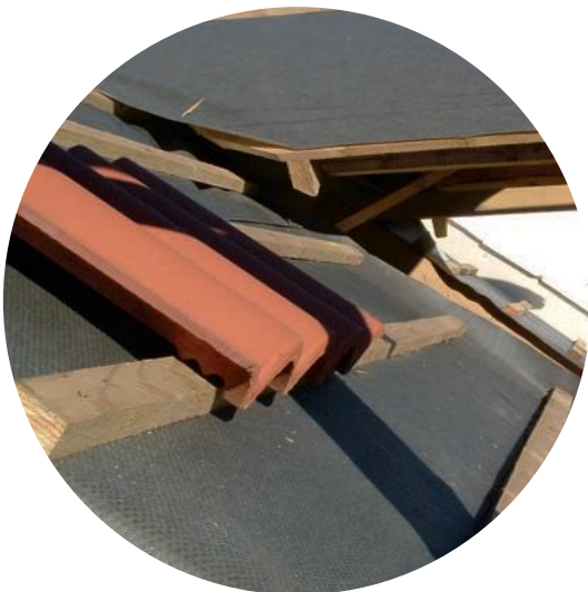
Az átszellőztetett fedési légrés hiánya
