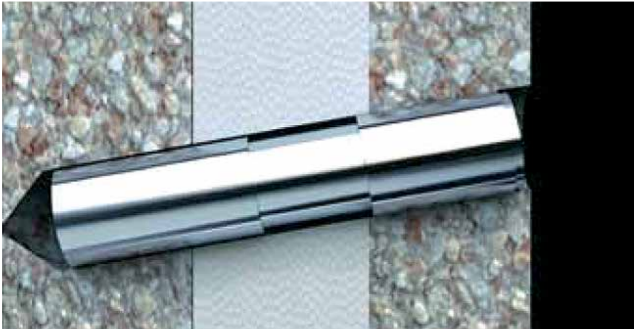
Panelkéreg megerősítése speciális kónuszos nemesacél csappal
