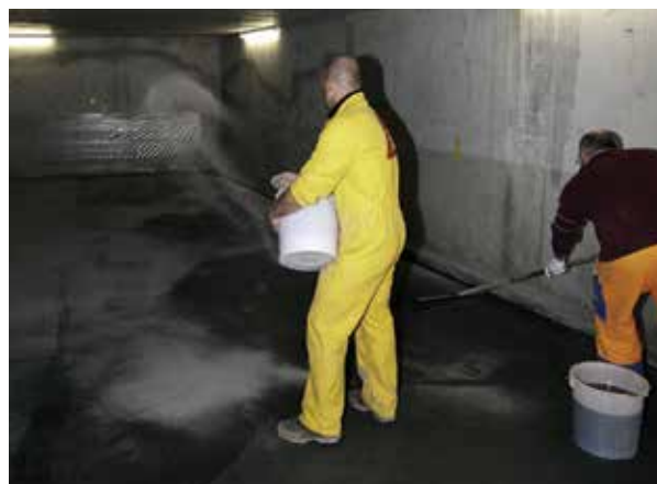
A bevonat csúszásmentesítése szemcsehintéssel
