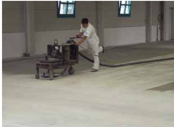
Beton alapfelület csiszolással történő felület előkészítése
