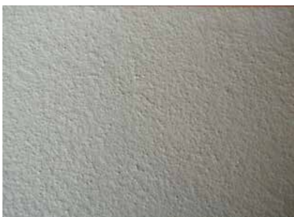
Szemcsehintéssel csúszásmentesített és fedőbevonattal ellátott padlóbevonat megjelenése
