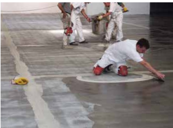
Foltszerű vagy teljes felületen történő vékony glettelés pórus zárás vagy nullglett
