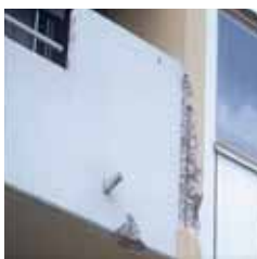
Károsodott balkonmellvéd
