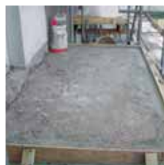
Az aljzat előkészítés után
