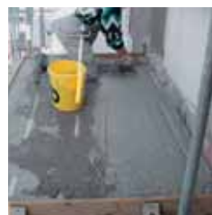
Tapadóhíd felhordása az előnedvesített aljzatra
