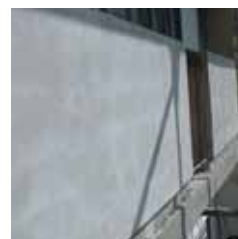
Helyreállított mellvéd (felületképzés nélkül)
