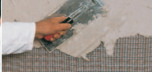
A vakolat egyszerű, vakolókanállal történő felhordása.
