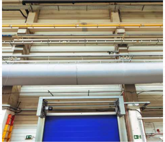
Adiabatus hűtés, a beltérben szövet légcsatornával - Magyar Suzuki Esztergom
