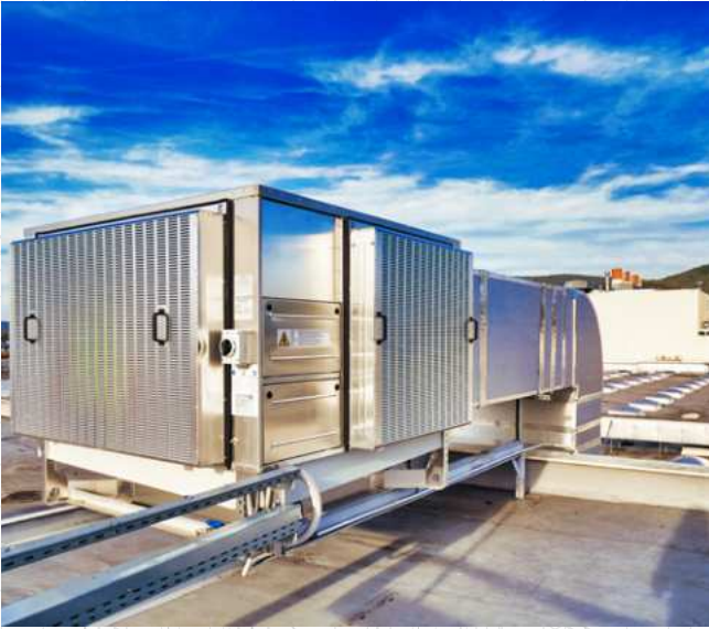
Adiabatus hűtés, a beltérben szövet légcsatornával - Magyar Suzuki Esztergom
