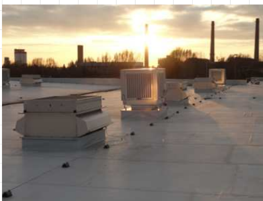
Az új csarnokrész már eredendően az új, korszerű rendszerrel került megépítésre: adiabaticus hűtés, légkezelők, természetes szellőztetés zsalus szellőzővel, hő- és füstelvezetéssel kombinálva
