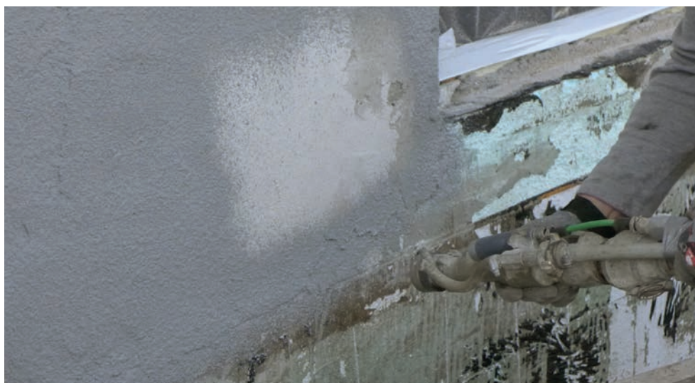
Anyag felhordása meglévő bevonatra gépi szórásos technikával
