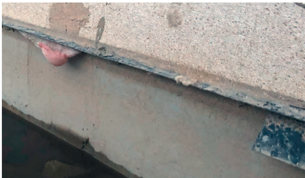
Keresztmetszeti szigetelés hagyományos lemezes megoldással
