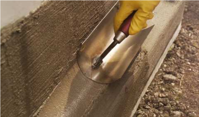
Ásványi hornyolt falcsatlakozás kialakítása hajlított simítóval
