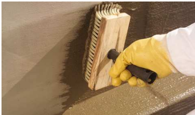
Szigetelőiszap felhordása a sávalap környékén
