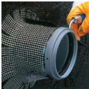
Lekenés a második bitumenréteggel
