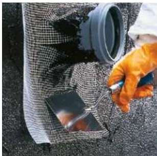
Beágyazás az első bitumenrétegbe
